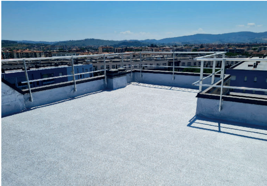
Foto Edificio di via Casella oggetto di manutenzio- ne straordinaria
