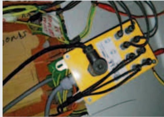
Le centraline comunicano i dati letti ad un touch screen posto in loco che scambia i dati con un concentratore situato nel locale tecnico all'ultimo piano della scala C del fabbricato di Viale Giannotti; il sistema è predisposto per essere remotizzato ad un indirizzario email definito, allertando qualora l'umidità dei setti portanti vada sopra il 18% con conseguente rischi di formazione di carie da funghi.
