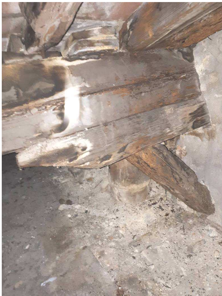
vista della mensola con puntello dell'appoggio sx di T8
