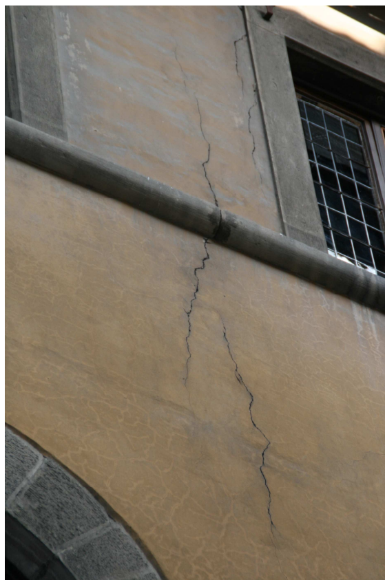
FOTO N. 14 Particolare lesione cornice marcapiano
