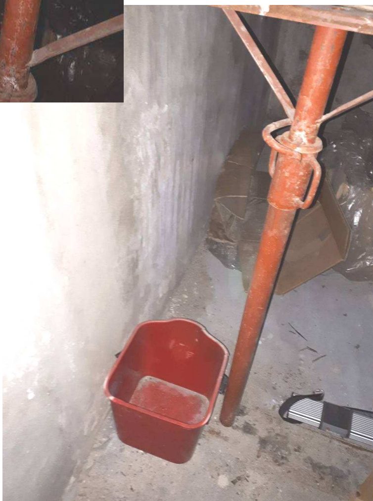
vista del secchio di raccolta delle infiltrazioni piovane dal tetto sotto l'appoggio destro di T3
