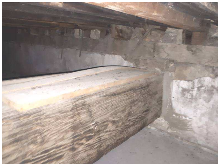
foto a fianco: vista dell'appoggi anteriore del falso puntone.
