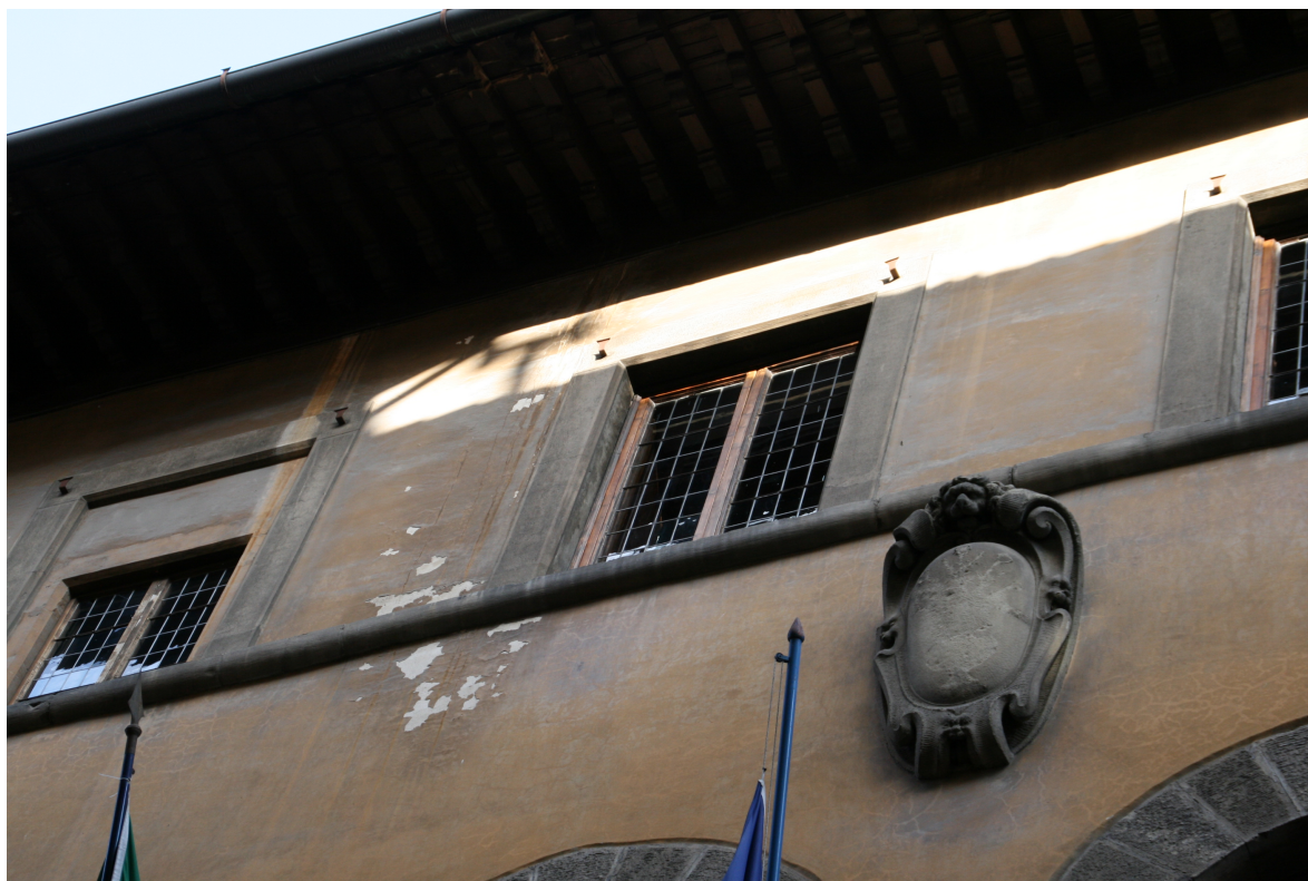
FOTO N. 16 Particolare intonaco ammalorato
