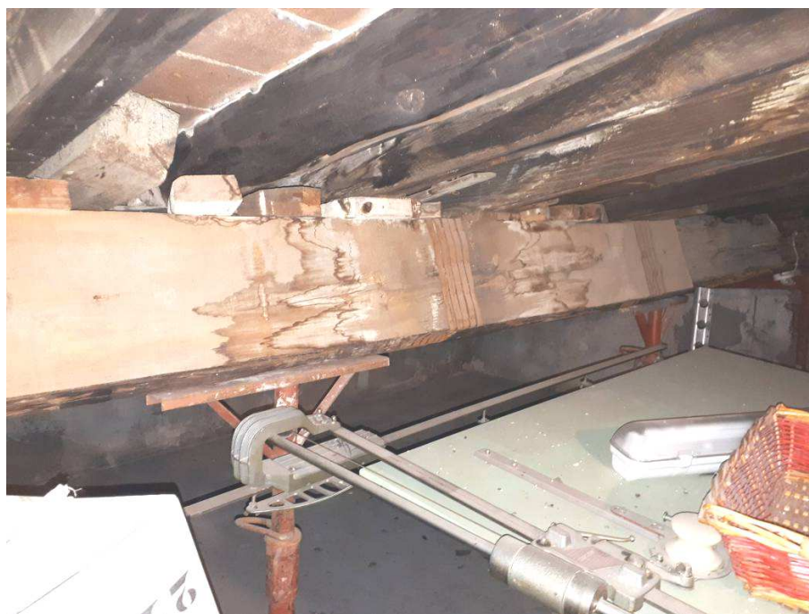
Vista del consolidamento di cui alla foto precedente con le vistose tracce di infiltrazioni piovane
