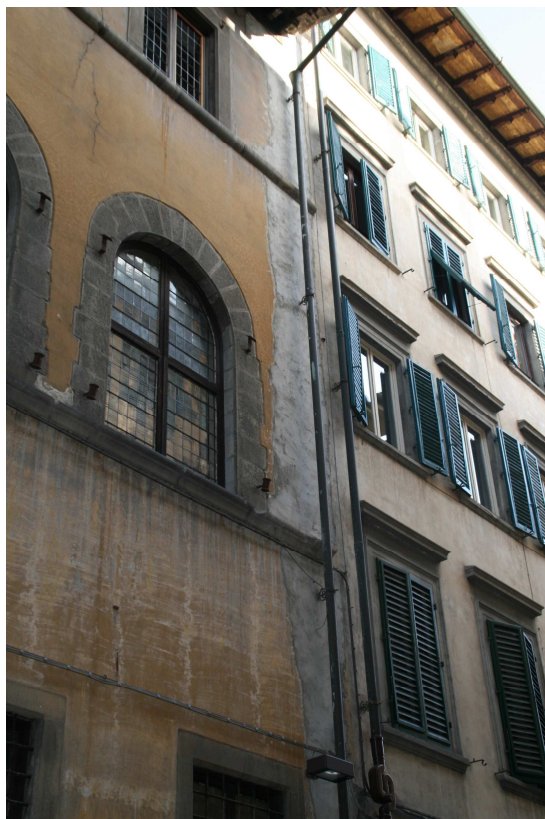
FOTO N. 15 Particolare intonaco ammalorato
