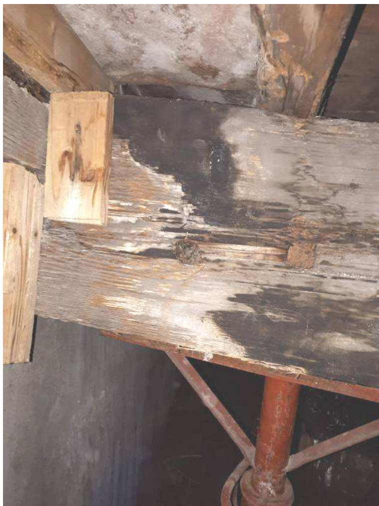
vista dell'appoggio dx di T3 con puntello e tracce di infiltrazione
