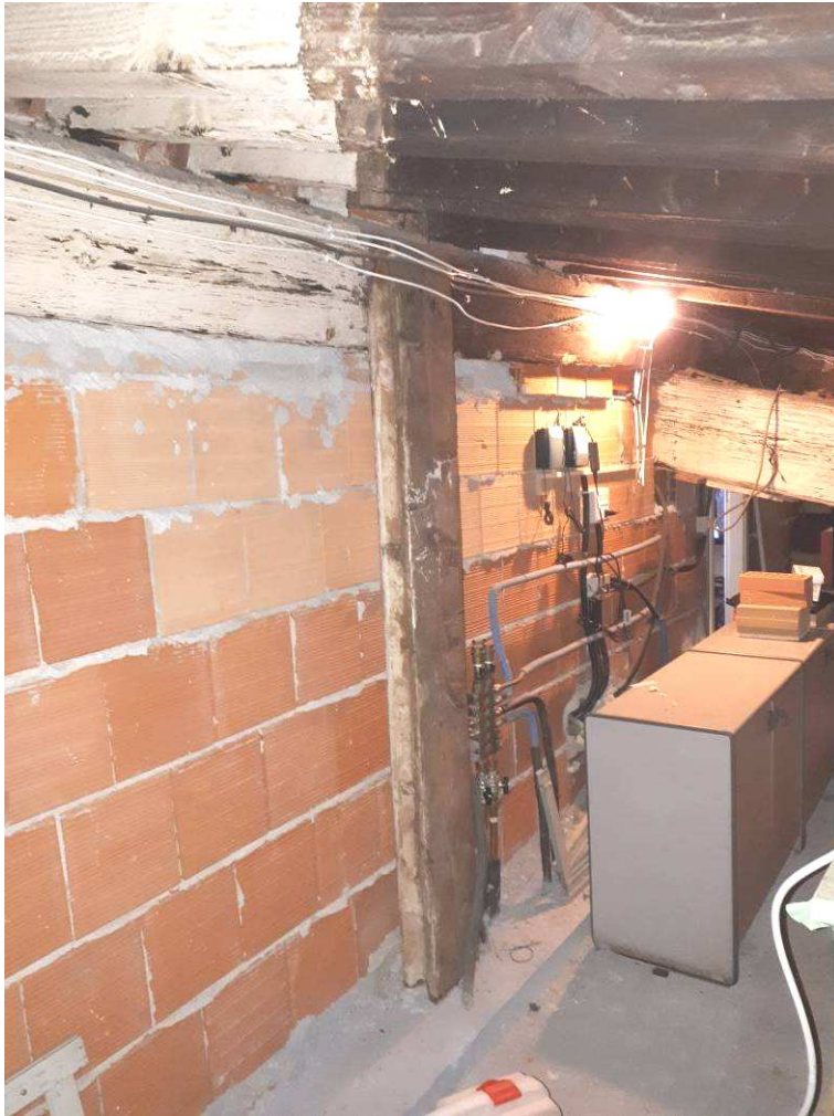
vista del puntello di legno su T5 e muro di tamponamento in intradosso della trave
