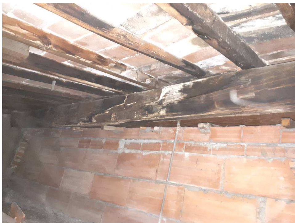
vista di T7 e delle tracce di percolazione/infiltrazione in luce
