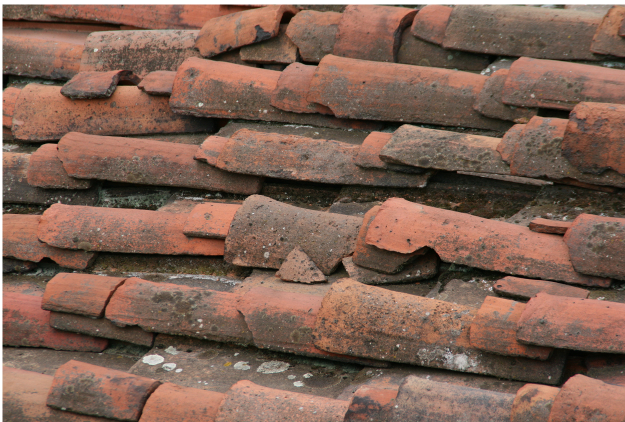
FOTO N. 20 Particolare tegole rotte e/o ammalorate
