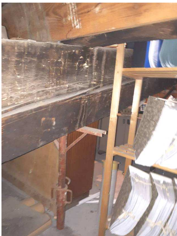
Foto a sinistra: campo d'incrocio tra fila arcarecci e falso punto con puntello di acciaio.
