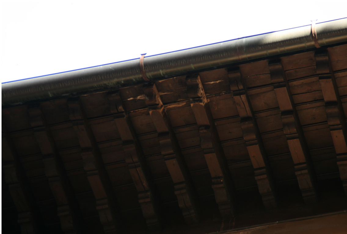
FOTO N. 17 Particolare Gronda prospetto principale – Correnti smensolati in triplice ordini
