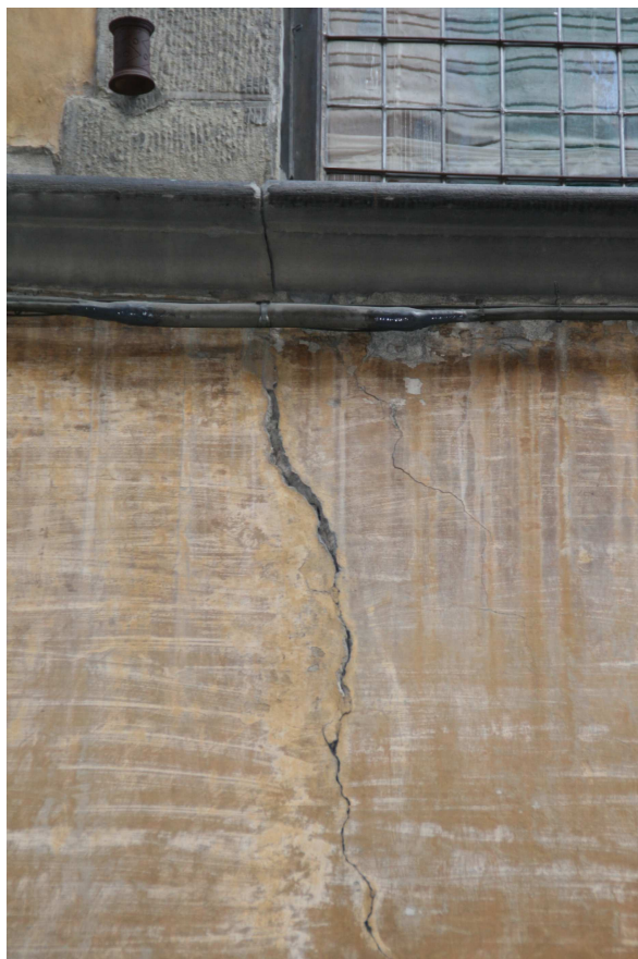
FOTO N. 13 Particolare lesione cornice marcapiano
