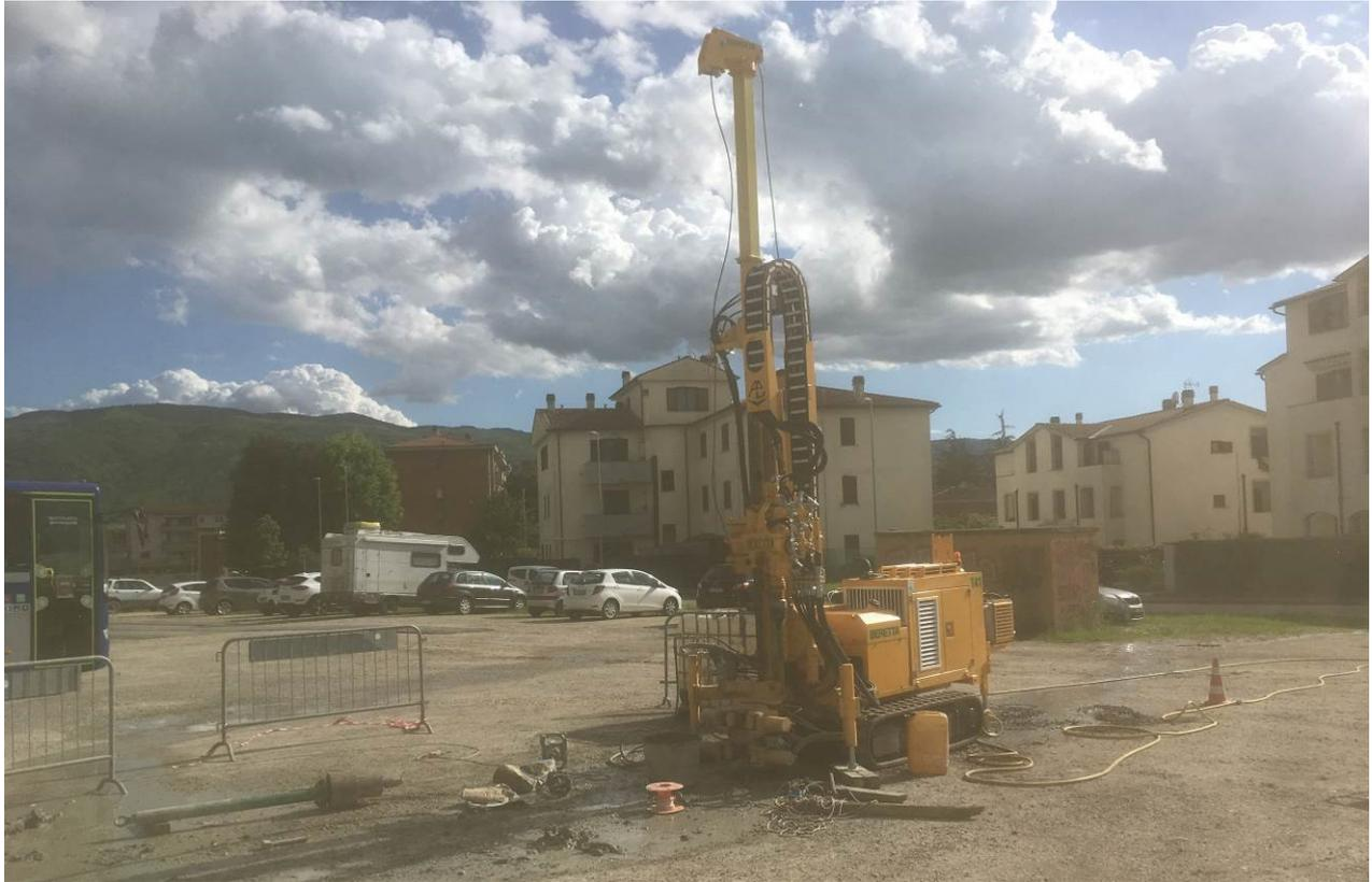
Fig.1 - Approntamento cantiere sondaggio s1
