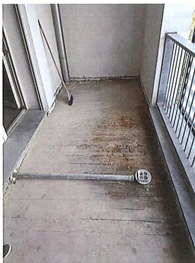
Da un'analisi svolta recentemente, si è riscontrato la presenza di un tasso di umidità anomalo in alcune membrature. Si è pertanto dato seguito al rifacimento dei pacchetti di finitura di alcuni dei locali in cui si è riscontrata tale umidità, in modo da scoprire le parti strutturali e far asciugare le fibre bagnate. Di fianco, la situazione riscontrata in uno dei terrazzi che è stato "scoperto".
