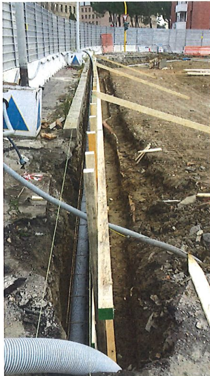
LAVORI DI SPOSTAMENTO DEL CAVO ENEL
