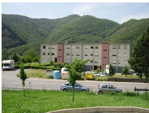
FABBRICATO ESISTENTE NELL' AREA P.E.E.P. FACCIATA PRINCIPALE - VISTA DALLA STRADA STATALE
