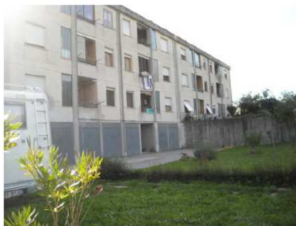
FABBRICATO ESISTENTE NELL' AREA P.E.E.P. FACCIATA TERGALE - VISTA DALLA FERROVIA
