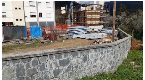
DETTAGLIO AREA NUOVO PARCHEGGIO. SULLO SFONDO IL NUOVO FABBRICATO IN COSTRUZIONE
